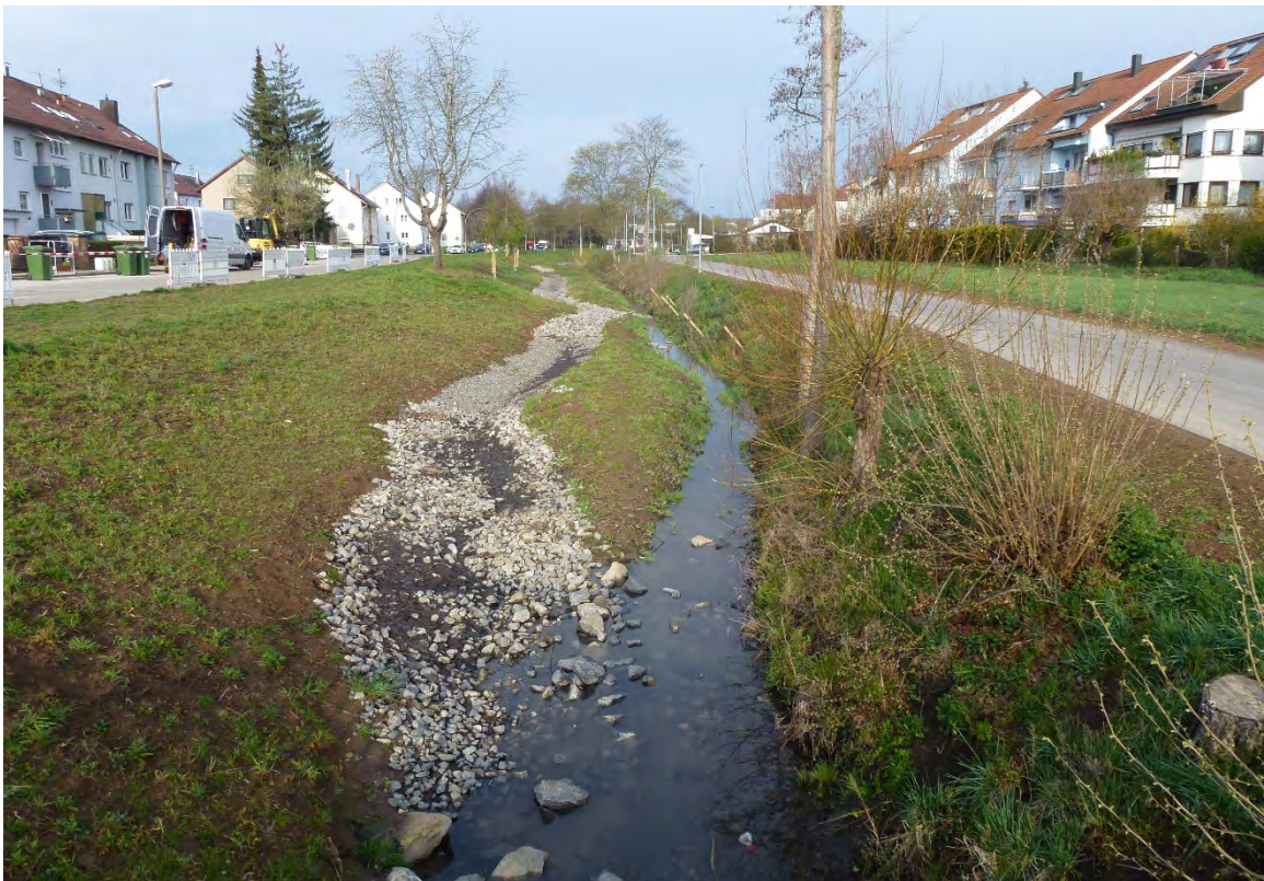
Abbildung 4: Lachengraben nach der Umgestaltung.
