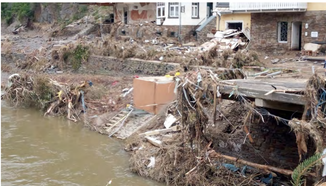
Abbildung 2: Der zerstörte Pegel Altenahr (Sockel in der Mitte) nach dem Hochwasser im Juli 2022. Quelle: Jürgen Michels / Struktur- und Genehmigungsdirektion Süd.
