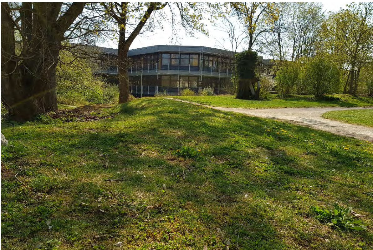
Abbildung 2: Erdschutzwall Schulzentrum Glemsaue.
